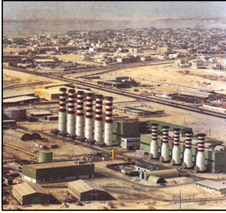
شكل ( ٤ ) محطة لتوليد الكهرباء.
