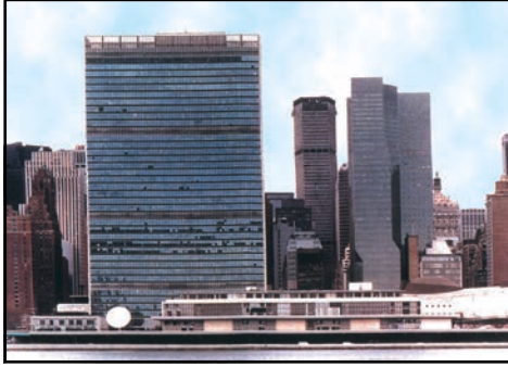
شكل (٩) مبنى الأمم المتحدة بمدينة نيويورك.
