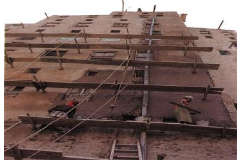
أشخاص يعملون في ترميم المباني الطينية
